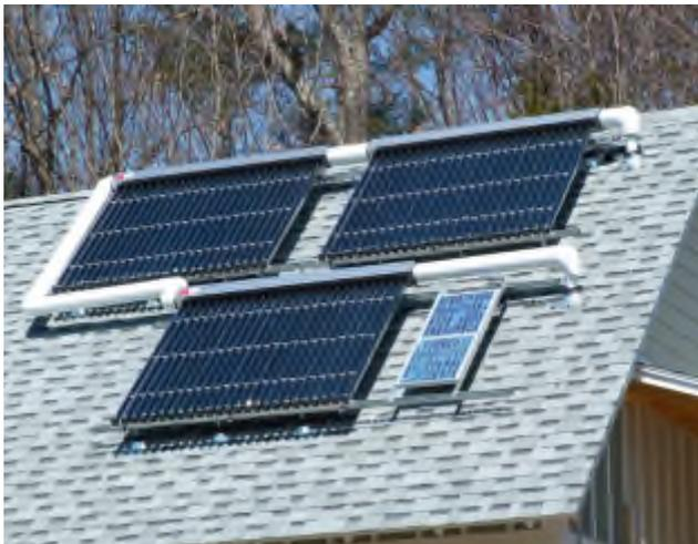
Рис. 5. Солнечное фотоэлектрическое тепловое устройство.
