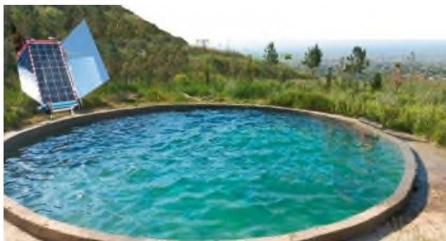
Рис.3. Бассейн объемом 80 м<sup>3</sup> и фотоэлектрическая система для капельного орошения.
